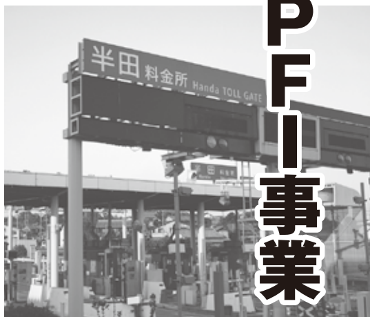
愛知県では有料道路8路線が民営化。愛知道路コンセッションが料金収受も行う。
